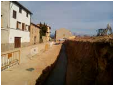
Inici de les obres al Carrer Sant Adjutori
