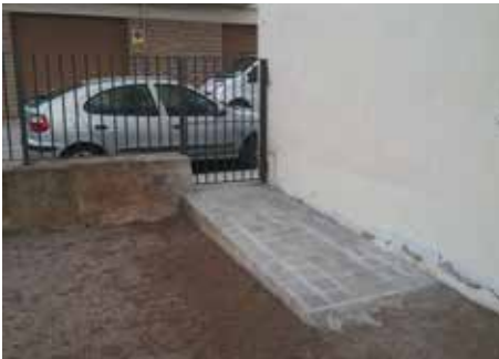
Rampa d'accés al pati del Centre Cívic
