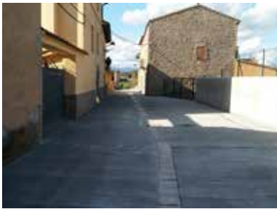
Final de les obres al Carrer Sant Adjutori
